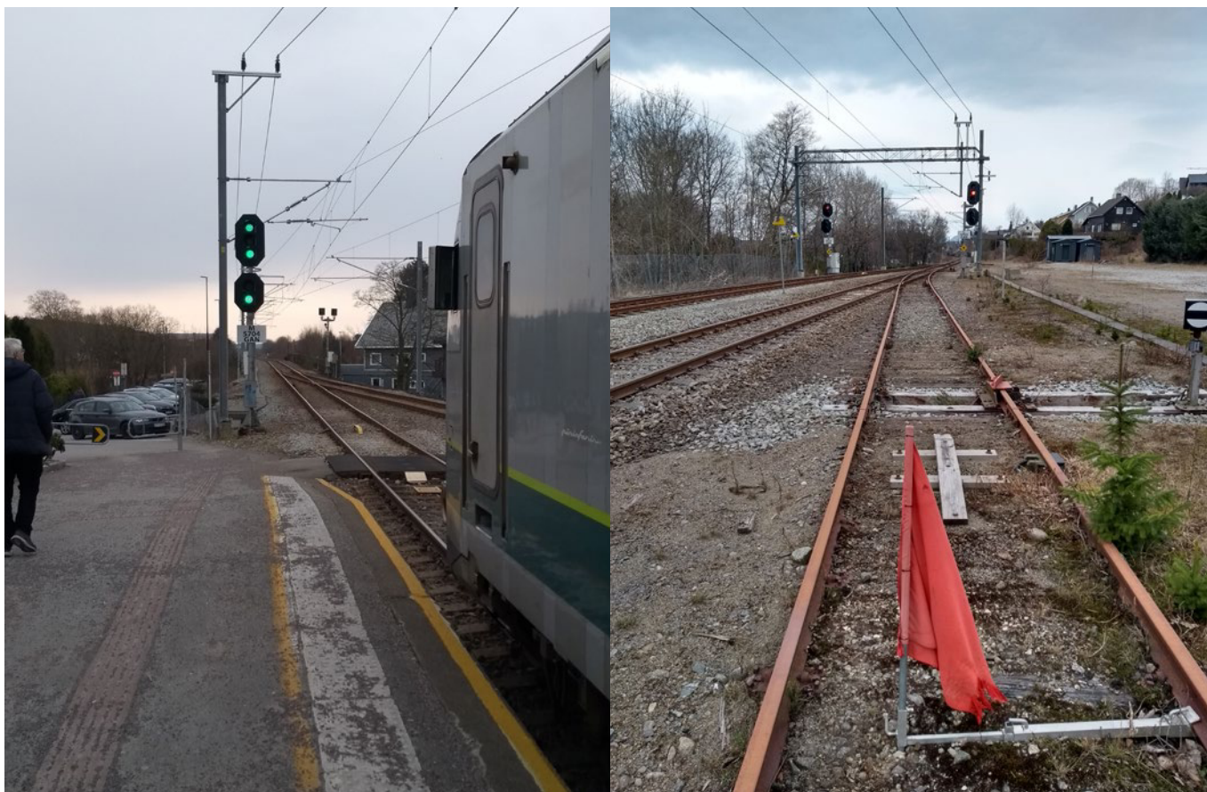
Ålgårdbanen greiner av ved Ganddal stasjon. Med dobbeltsporet skal ny stasjon bygges sør for Kvernlandsveien. Foto: For Jernbane
