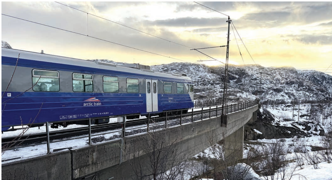
Fra Ofotbanen 4.11.25. Arctic Trains motorvognstog type 69 under opphold på Søsterbekk hp med siste vogn ute på Nye Norddalsbrua (ferdig 1988). Bildet er tatt ifm. togtur for deltakerne på jernbanekonferansen Arktisk Testarena.
