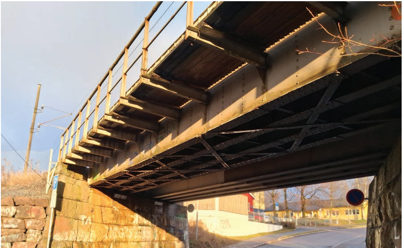
Gjøvikbanen krysser Båhusveien i Oslo. Foto: For Jernbane
