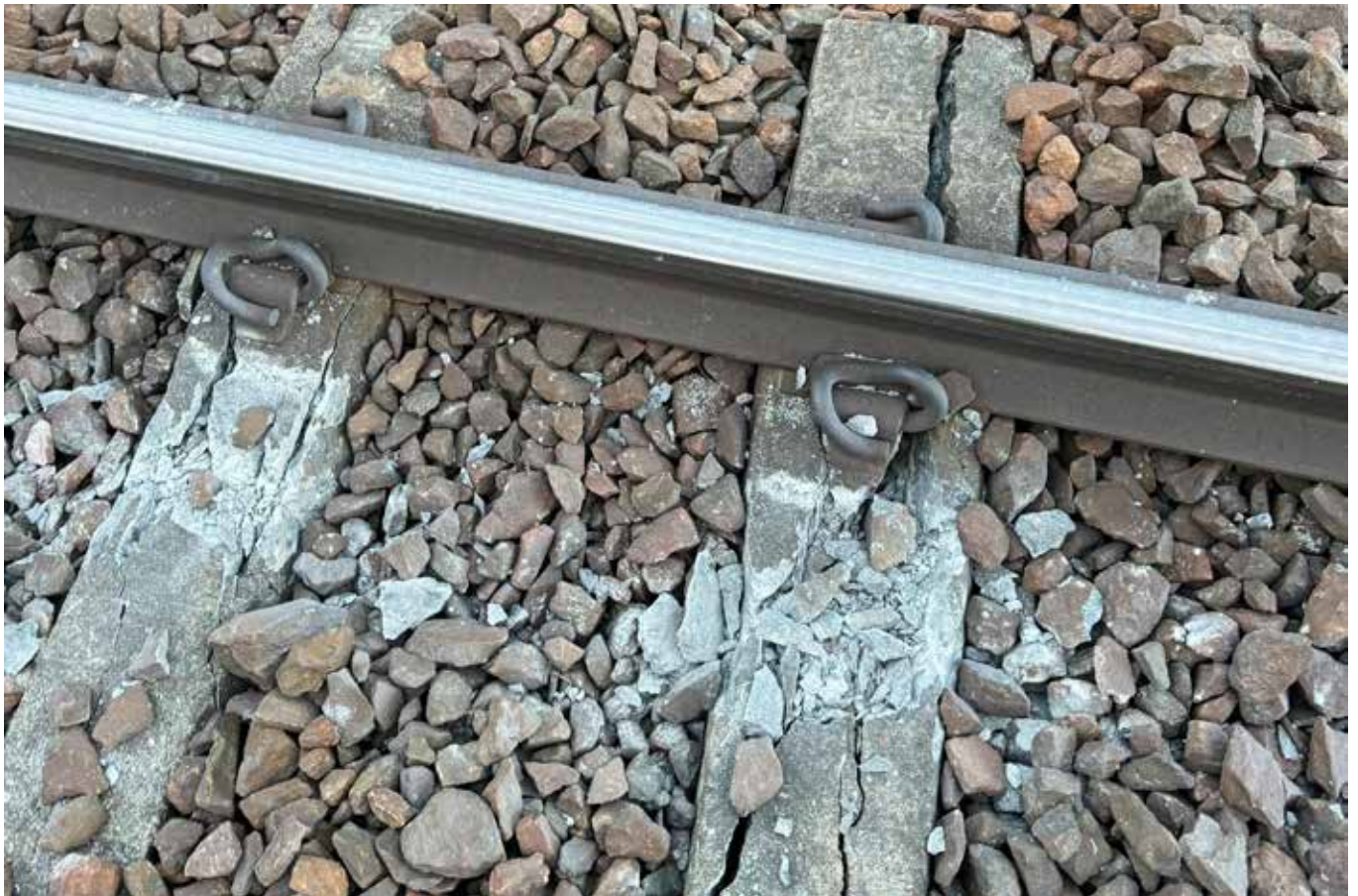
Avsporinger kan ødelegge kilometervis med sviller. Foto: Bane NOR
