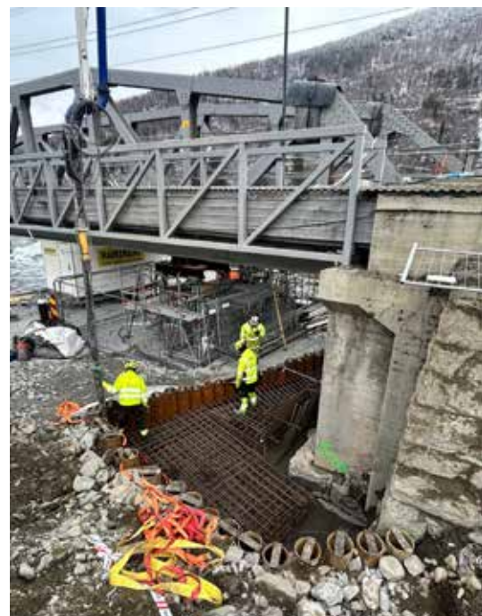
12. mars 2025. Arbeid med støping og spunting rundt landkaret. Foto: Bane NOR
