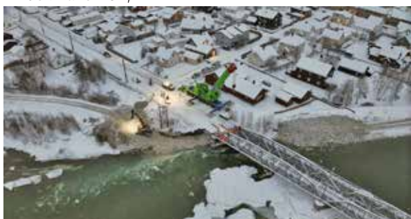
23. januar 2025. Otta bru, søndre landkar. Jobber med å fjerne is og sikre bru. Foto: Bane NOR
