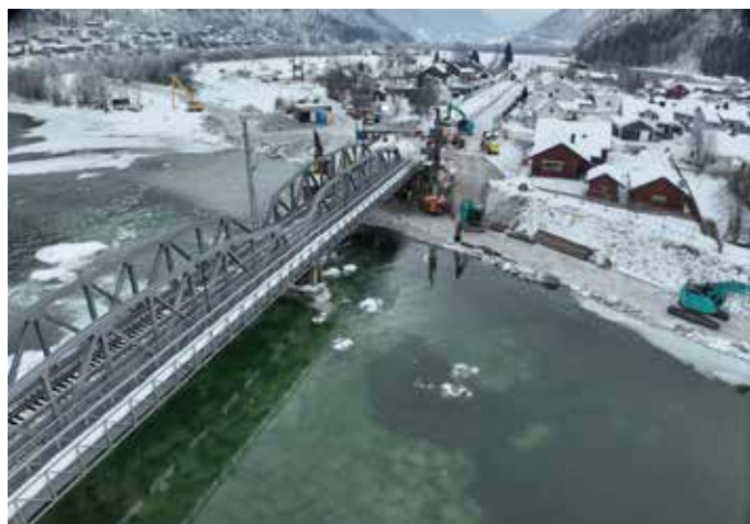
8. februar 2025. Bildet viser arbeidet etter vi har fjernet is. Det er anlagt en voll og arbeidet med å reparere og justere landkar er i gang. Foto: Bane NOR.
