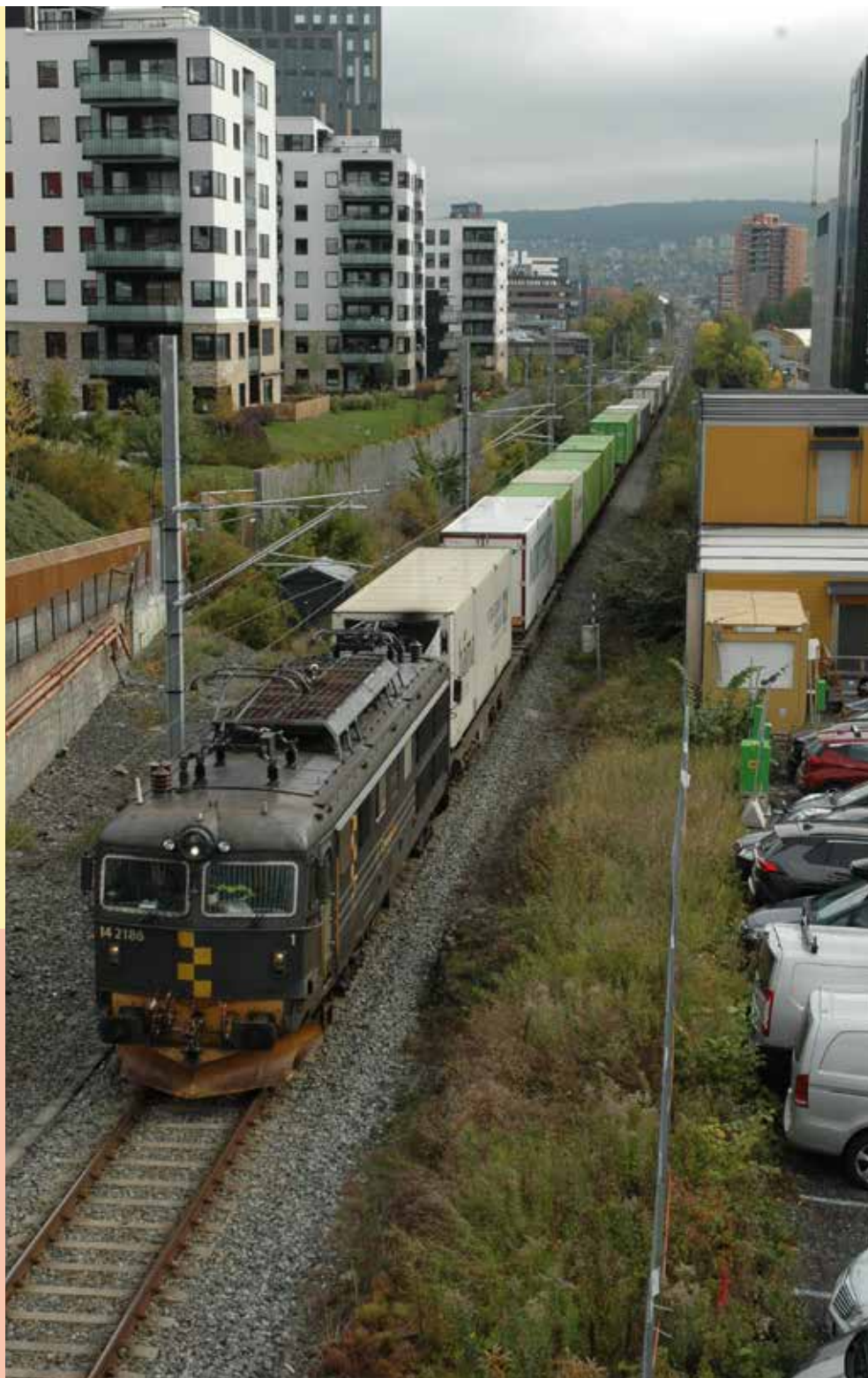
Alnabanen i Oslo fylte 125 år 20. januar 2026! Banen er 5 km lang og forbinder Hovedbanen/Alnabruterminalen med Gjøvikbanen. Trafikken består av godstog mellom Alnabruterminalen og Nygårdstangen i Bergen og arbeidstog. Alnabanen er også omkjøringsrute for Drammensbanen. Foto: For Jernbane
