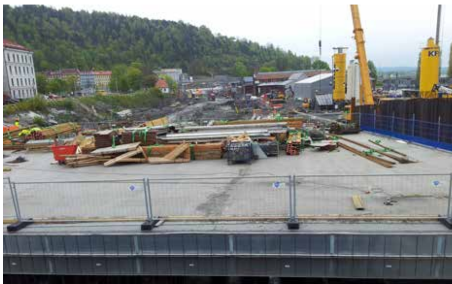
Fra bygginga av Follobanen i Oslo i 2017, Foto: For Jernbane
