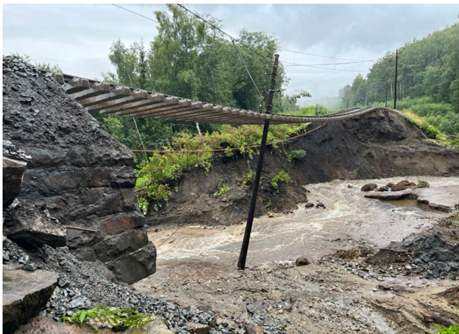
Ekstremværet "Hans" i august 2023 gikk hardt utover jernbanen. Underbygningen på linja Roa-Hønefoss ble her skylt bort. Her trafikerer ordinært godstogene mellom Bergen og Oslo, samt fjerntog når Drammensbanen er stengt. Foto: Per Edvin Fjeldbu, Bane NOR
