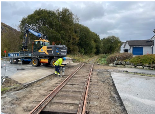
Sporarbeid på Ålgård høsten 2022 i forbindelse med utbedring av planovergang
