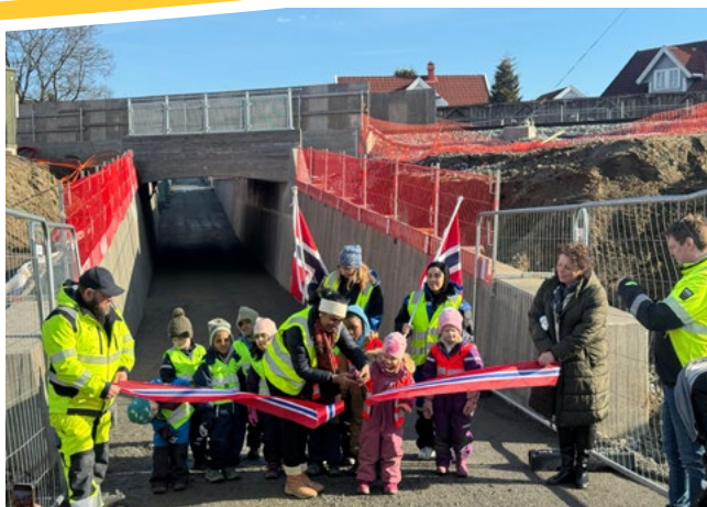
Nordby barnehage klipper snora til den nye undergangen. Foto: Synne Gevoll Østerlie, Bane NOR
