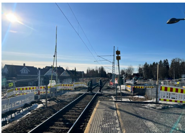
Den gamle planovergangen på Nordby. Foto: Anna Langhammer, Bane NOR
