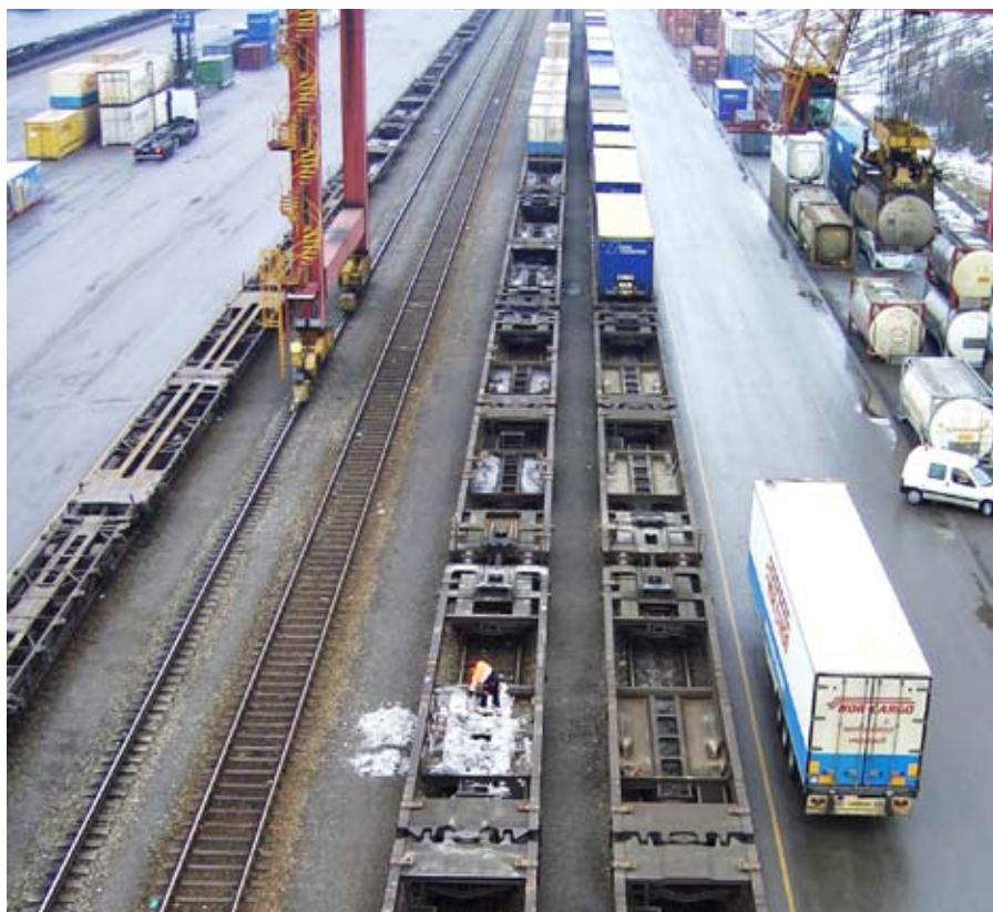
Lastegate med kran på Alnabru godsterminal
